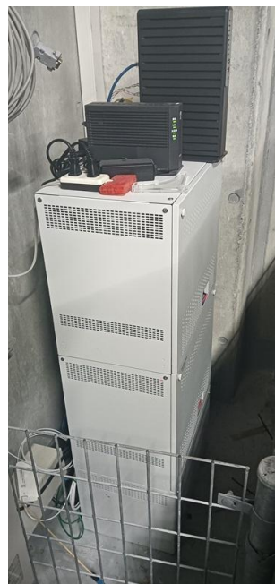
【万国津梁館電話交換機改修工事(R7-2)】 電話交換機（PBX）写真 サミットホール地下1階 倉庫(1)
